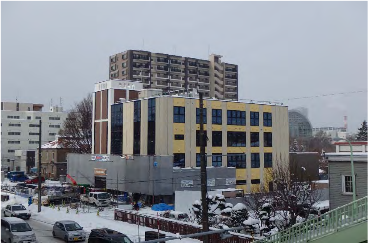
12月7日現在 建物の囲いがはずれ全体像が見えてきました
