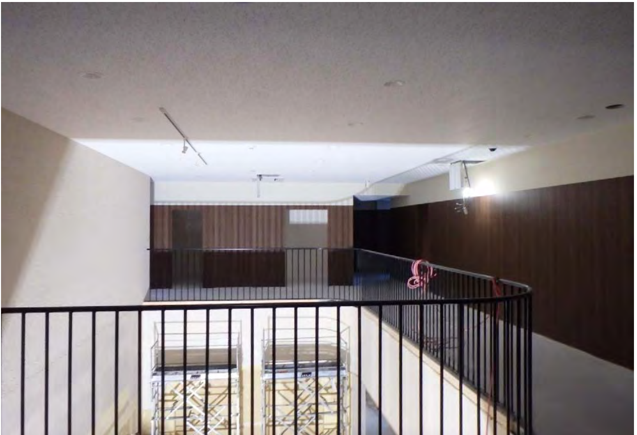
12月13日現在 2階ホールのクロス貼り完了しました
