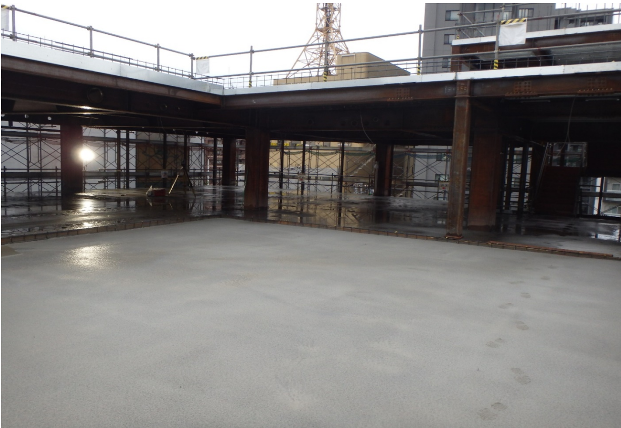
9月28日現在 4階床までコンクリート打設、屋上スラブ配筋が完了
