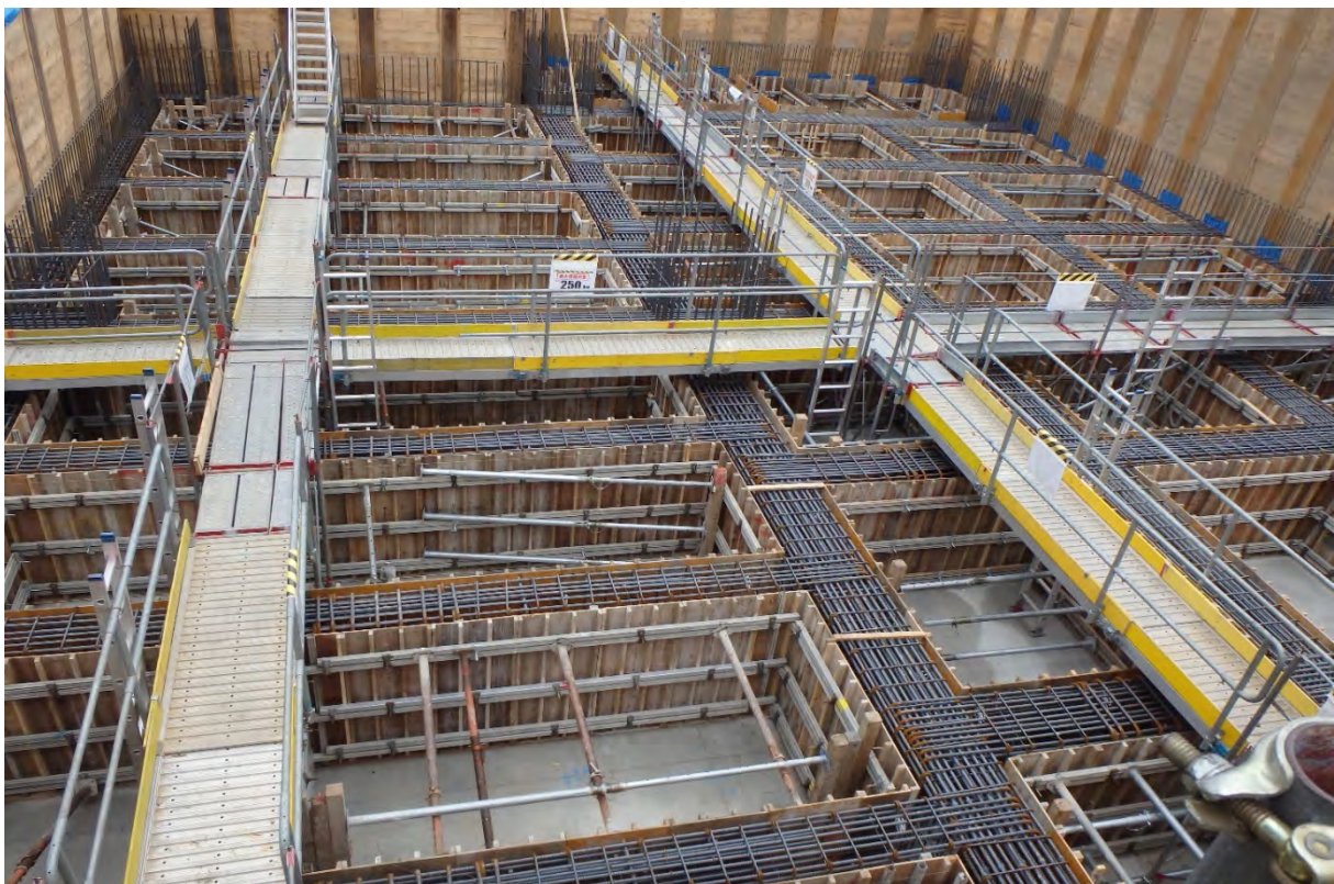
7月4日現在 基礎の配筋工事、型枠工事完了
